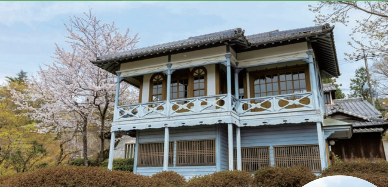
旧井上家住宅西洋館 井上農場住宅の迎賓館として使われていた。現在は豊田市民芸館敷地内に移築されている。
