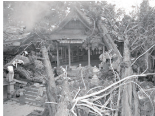
昭和34年(1959)に発生した伊勢湾台風での被害の様子(挙母神社)
