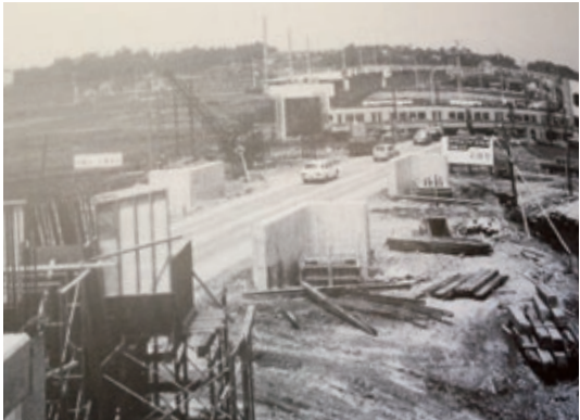
国鉄岡多線の建設（豊田市・昭和49年）
