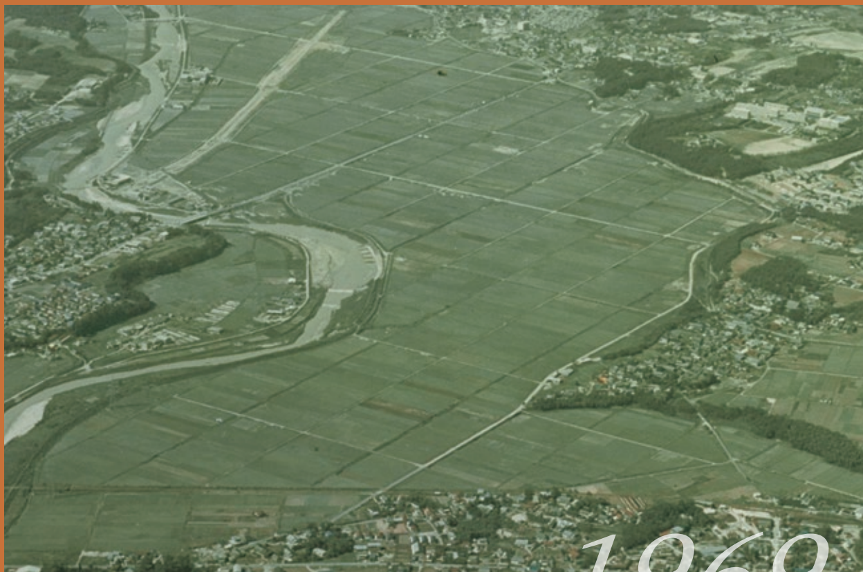
ほ場整備後、南部工区周辺の空撮。入り組んだ田が整然と整備された
