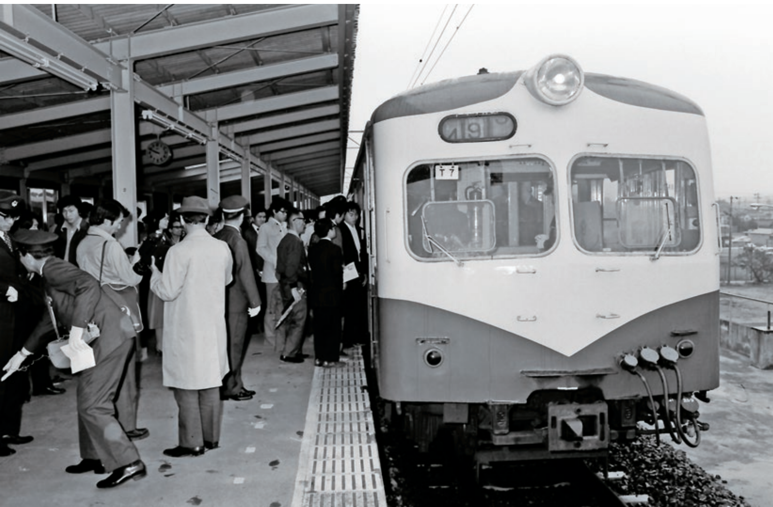
昭和51年(1976)、旧・国鉄岡多線旅客営業開業日の様子
