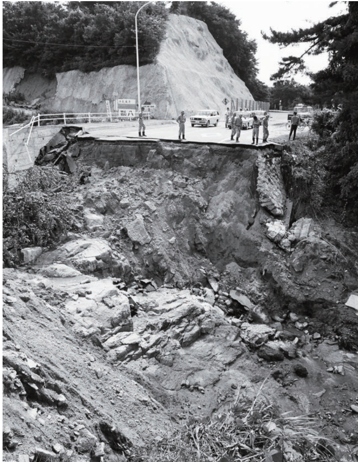
ほ場整備事業における47・7豪雨災害復旧工事は1年ほどで完工した(写真は豊田市勘八町地内国道153号)
