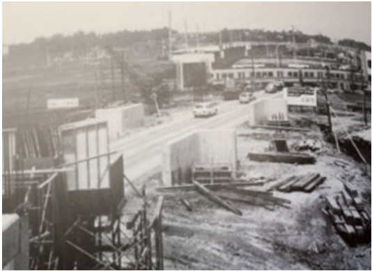
国鉄岡多線の建設（豊田市・昭和49年）
