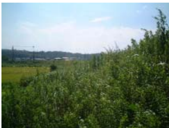
愛環鉄道から南側の堤防の様子
