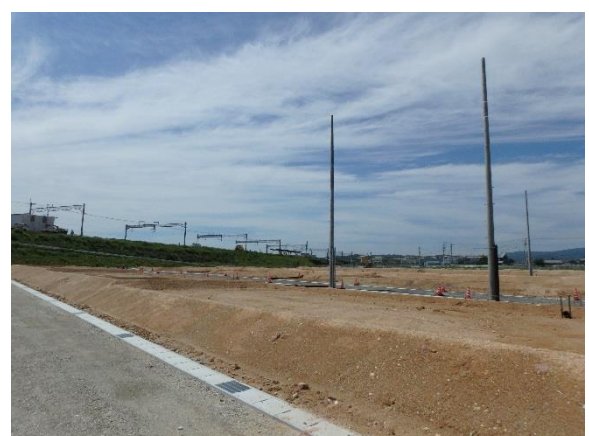
⑤ 宅盤整地完了（22街区）
