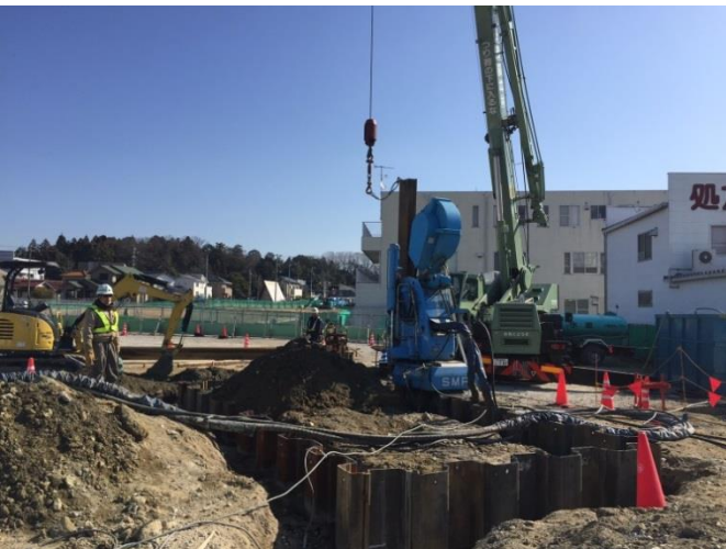
④ 雨水排水管推進工事 土留工事
