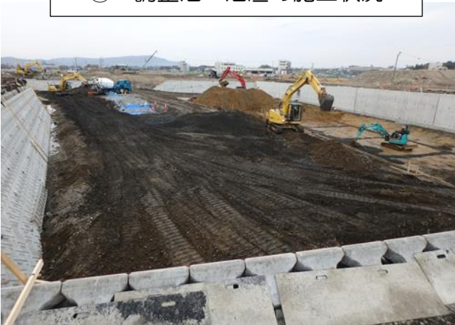
① 調整池 池底の施工状況
