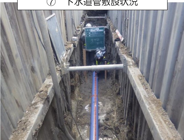
⑦ 下水道管敷設状況
