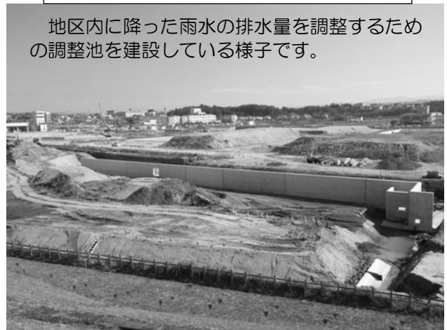
⑤調整池の擁壁工事
