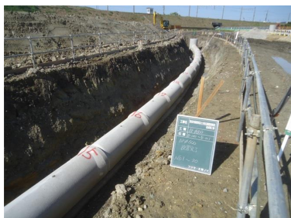
〈配水管敷設工事〉
