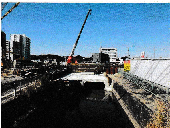
④国道419号（枝下用水）拡幅工事
