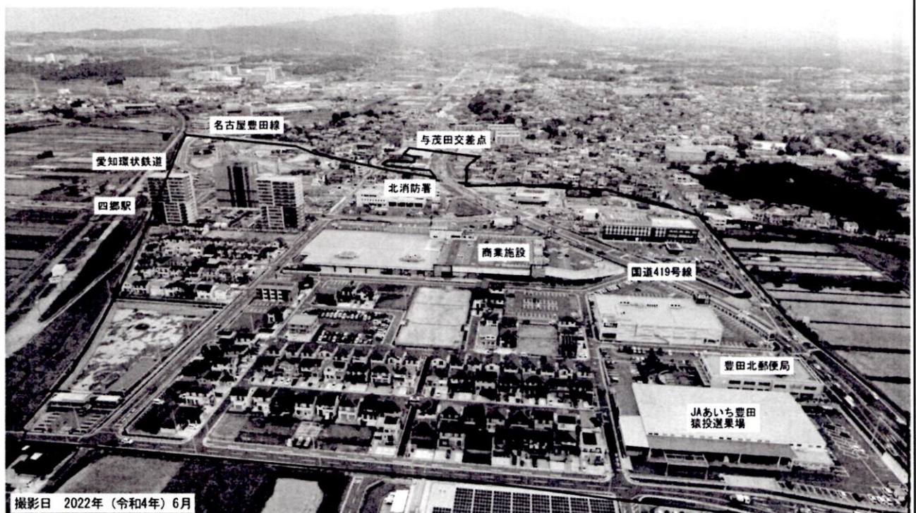
南側から地区全体を望む 令和4年6月撮影
