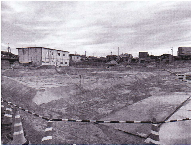
② 6-2街区 整地状況
