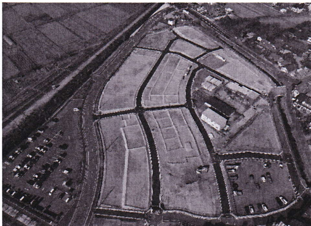
④ 組合事務所周辺 工事状況
