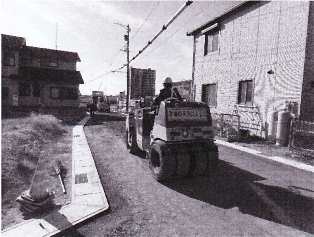
① 区画道路6-10号路盤工事
