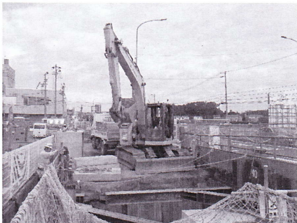
① 5号水路施工状況（JA東側）
