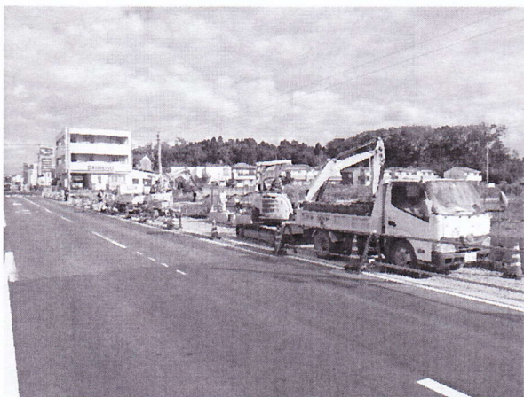
② 区画道路14-4 施工状況
