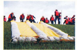
●水防工法(シート張工)
